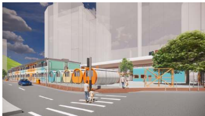
▲ 仁濟軒以組裝合成建築法興建，預計將於2023年第三季落成及入伙，提供212個房屋單位，供約550名租戶居住 ▲
